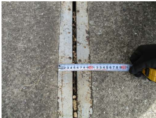
신축이음 유간거리 측정
