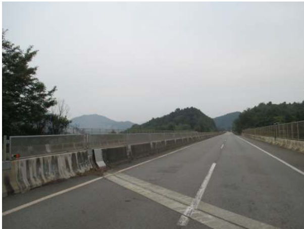
교면 포장 상태 양호
