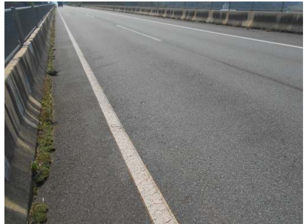
교면 포장 상태 양호
