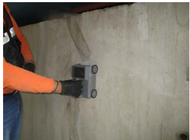
철근 피복두께 측정
