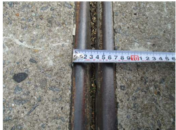
신축이음 유간거리 측정
